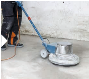
Boden abschleifen
