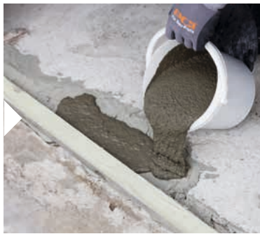
Einfahrtsschiene mit fließfähigem Mörtel hintergießen
