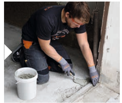
Alternativ mit Mörtel ausspachteln
