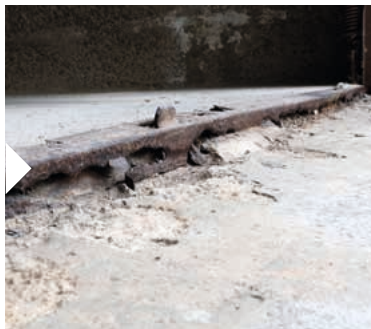
Höhenversatz an der Einfahrtsschiene mit Rampe angleichen
