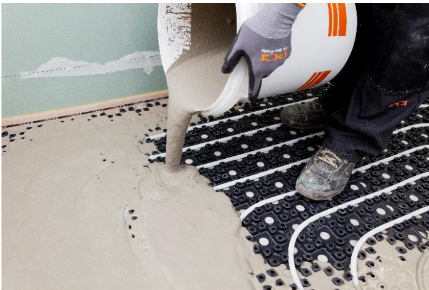
Die effizienten und nachhaltigen PCI-Systemlösungen für die einfache energetische Sanierung von Fußboden-Heizsystemen (Im Bild der Einbau eines Dünnschicht-Warmwasser-Heizsystems) ( Link zum hochauflösenden Photo)
